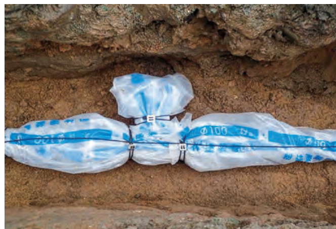
(ポリスリーブ被覆施工後)
