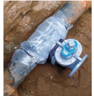
(不断水分岐工 完了)
