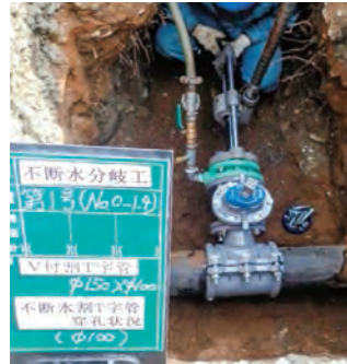
(不断水分岐工 施工状況)
