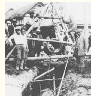
昔の工事の様子
