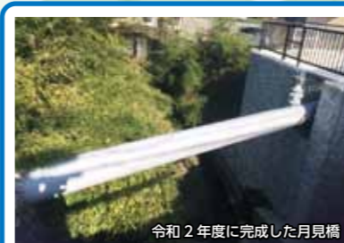
令和2年度に完成した月見橋
