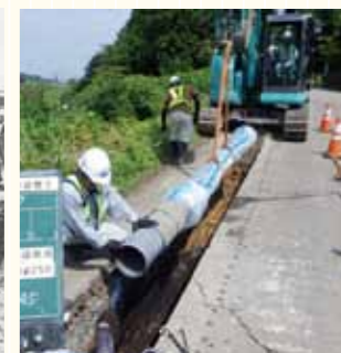
現在の工事の様子
